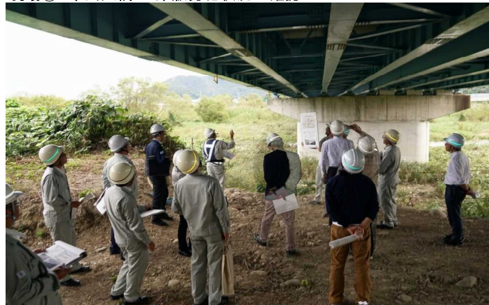
現場② 市川大橋5 床版劣化状況の確認
