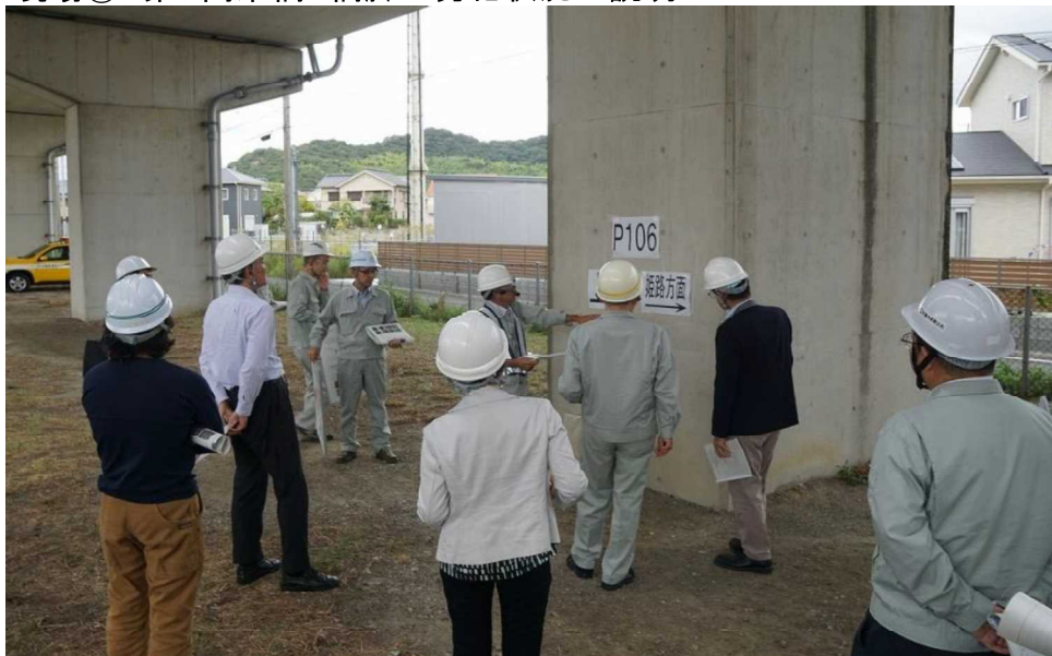
現場① 第2高架橋 橋脚の劣化状況の説明
