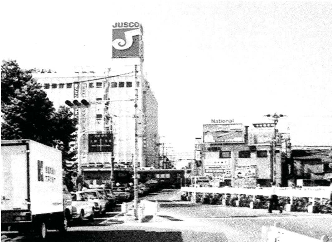
阪急電鉄宝塚線（川西能勢口駅付近） （整備前）
