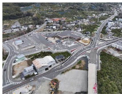
道の駅「海南サクアス」
