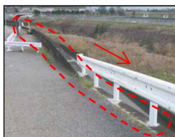
防水壁を設置しました。
