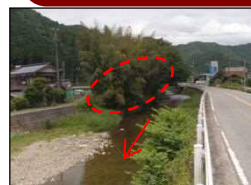
部分的に狭いところを 拡げました。
