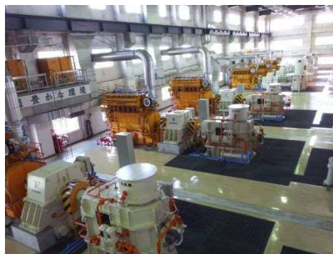
ポンプ設置状況(口径2,300m×6台)
