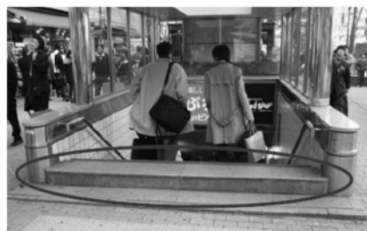
出入口階段のマウンドアップ (引用: 東京都地下空間浸水対策ガイドライン)
