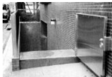
防水扉 (民間ビル) (引用: 広島市HP)
