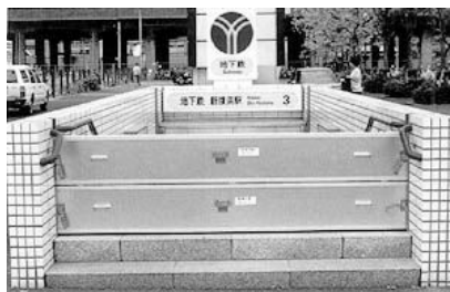
地下鉄駅出入口の防水板 (引用: 国交省HP)
