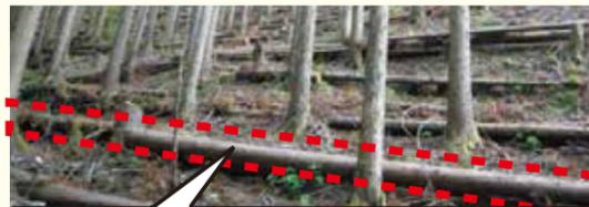
伐採木を利用した簡易な土留工により降雨による表土の流出を緩和します。
