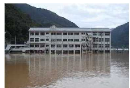
H26. 8避難所2階の浸水（徳島県）
