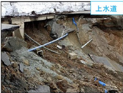
融雪災害による管体の破断 (新潟県柏崎市)
