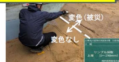
洗浄後(ろ過砂への赤土の混入)
