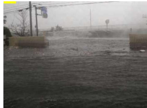
写真10. 西側防潮堤からの越波状況
