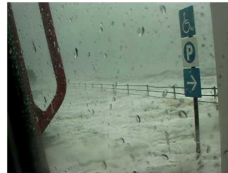
写真2. 南護岸からの越波状況
