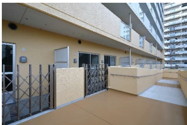
車椅子使用者の避難に配慮した住戸整備
