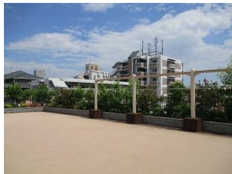
植栽による屋上緑化（尼崎市）
