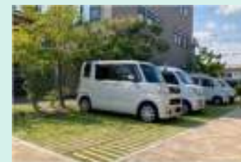
アスファルトを撤去し芝生化された駐車場
