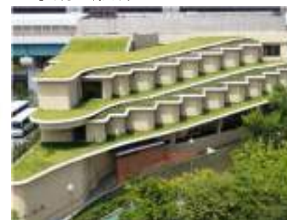
芝生で覆われた屋上
