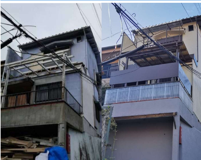
▲空き家を改修し、シェアハウスとして利活用
