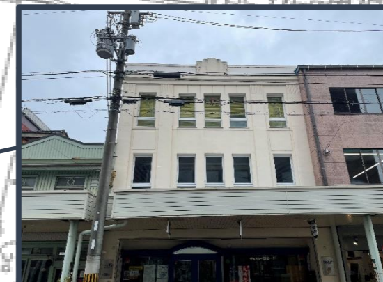
①こうじゅ舎（旧中源商店） 昭和前期に建てられたRC造3階建ての建築物。現在は事務所として利用されており、巻物風のモチーフが特徴的
