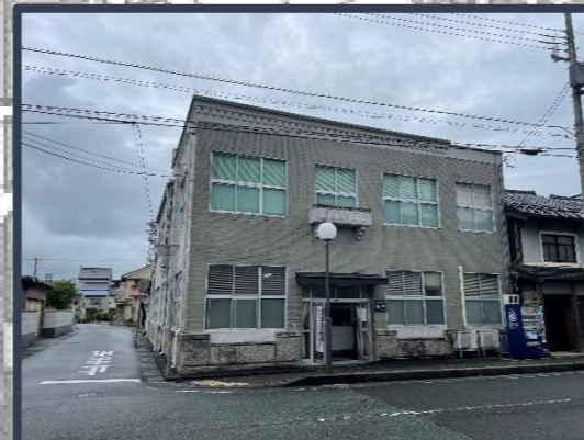
④服部本社 昭和2年に建てられたRC造2階建ての事務所。軒下のコーニスや浮彫模様が施されたバルコニーが特徴的
