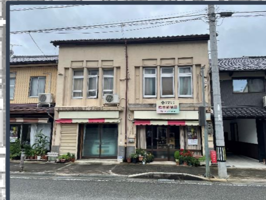
③橋本結納店 昭和前期に建てられたRC造2階建ての店舗。窓の間に立てられた間柱は断面形状がテーパースされており特徴的
