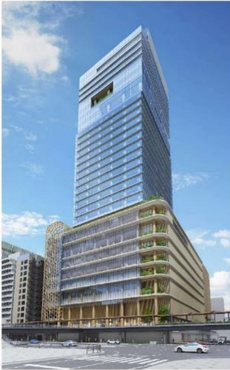
▲全体外観イメージ（南東より）
