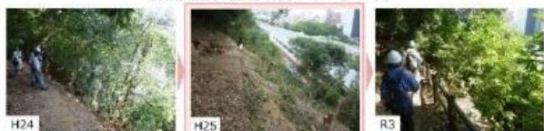
斜面林の大径木化に伴い災害の恐れ 樹木の択伐（機能維持増進） 安全に再生された樹林
