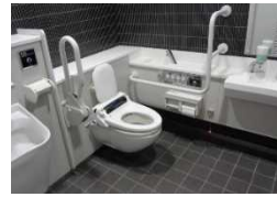
〔バリアフリートイレの設置〕
