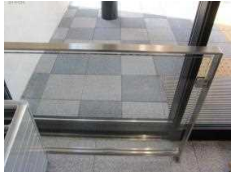
隙間も適切でデザイン的にも優れた自動ドアの巻き込み防止柵
