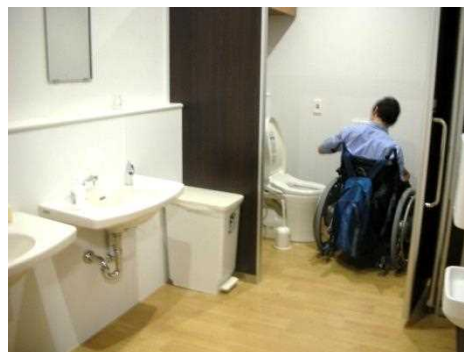
設備が整っており広くて使いやすい 一般便所
