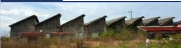
神結酒造の「のこぎり屋根」の建物。全長約50メートル。このうち3分の2が解体される。全国でも珍しい光景で、関東から愛好家が訪ねて来ることもあったという
