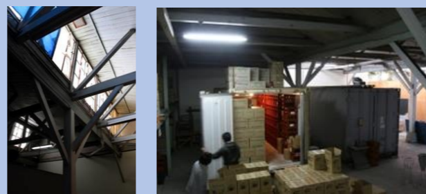
建物の中。漏れる光が往時の面影を語るようだ 残ったのこぎり屋根の建物は、倉庫や冷蔵庫として活用する
