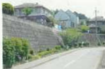
擁壁法尻部の緑化
