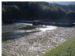
石張による河川護岸 (円山川(竹田地区)・朝来市)
