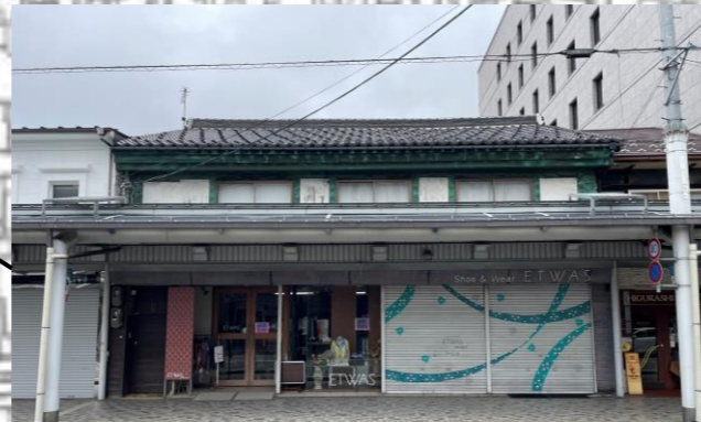
⑭藤井家住宅 昭和前期に建てられた木造2階建ての店舗。正面2階の開口部や壁面、箱軒が銅板で覆われており防火性能を持たせている点が特徴。
