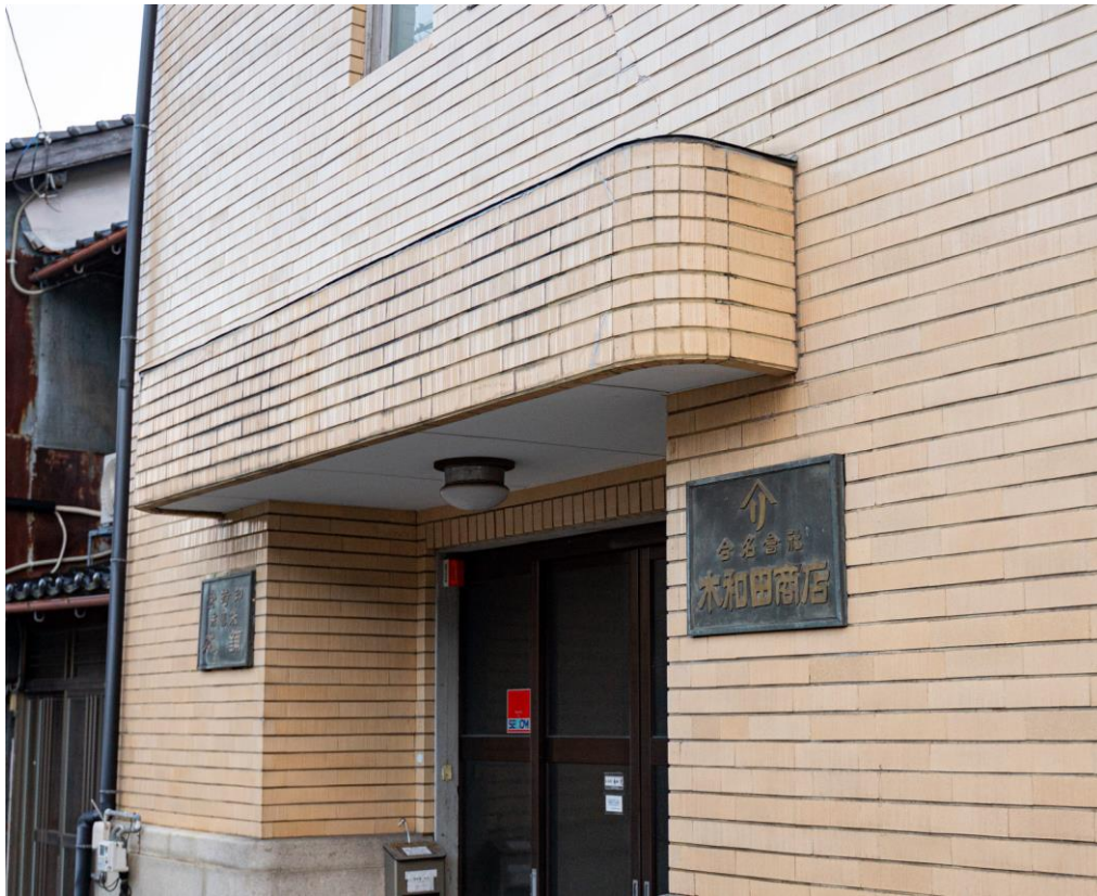
事務所棟ポーチ端部の曲面部分
