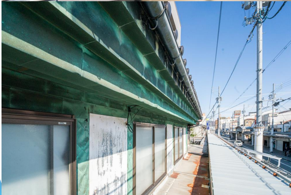
壁面や箱軒に葺かれている銅版
