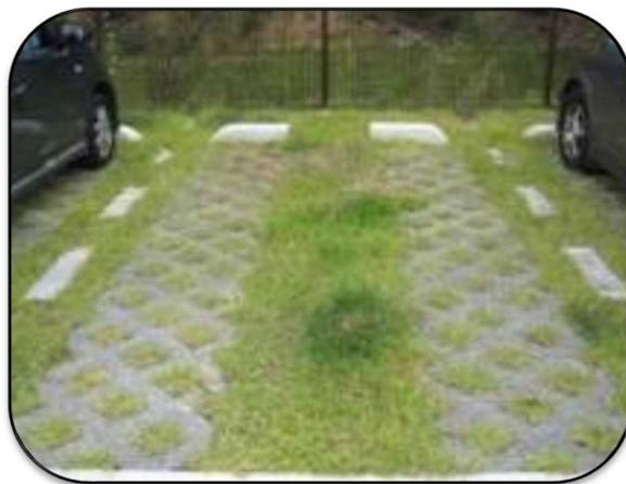
保護材による車輪部の補強
