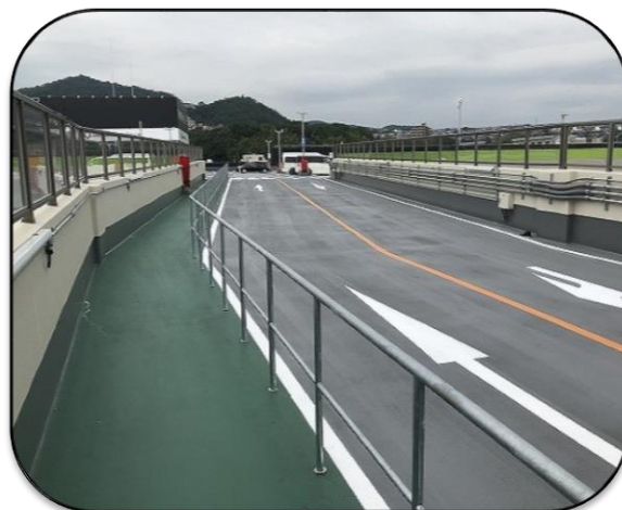
歩車分離された建物間の連絡通路
