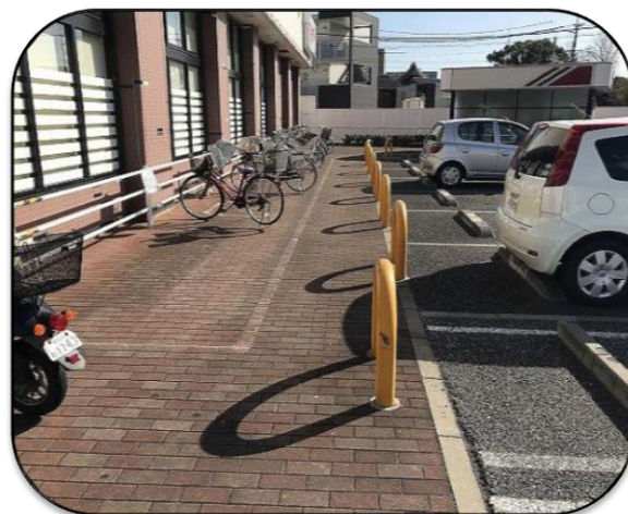
防護柵の設置
