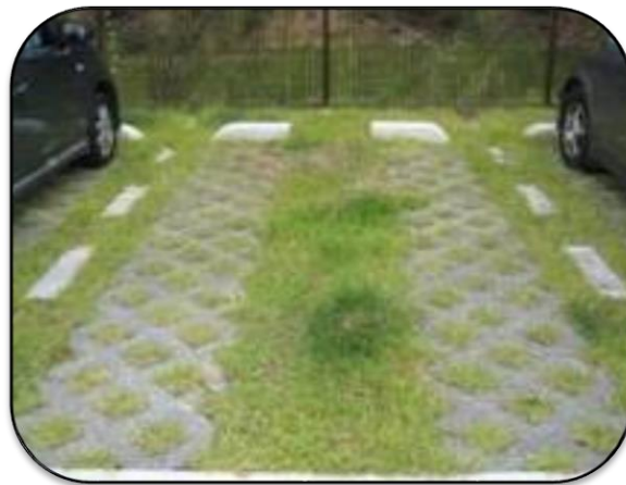
保護材による車輪部の補強
