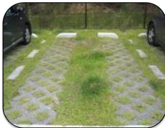
保護材による車輪部の補強
