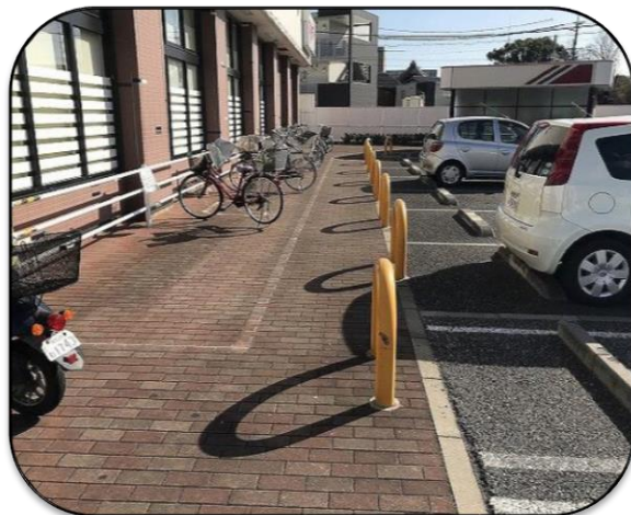
防護柵の設置
