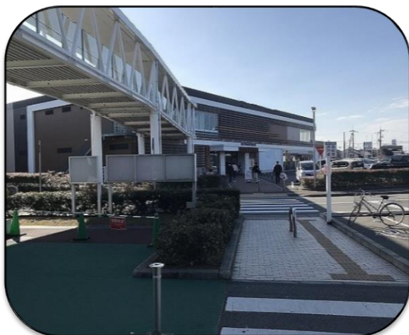
建物間を接続する歩行者用デッキ
