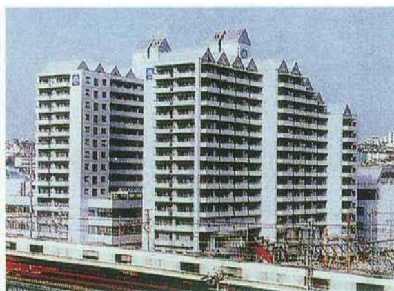
第1地区完成写真(レバンテ2番館、3番館)
