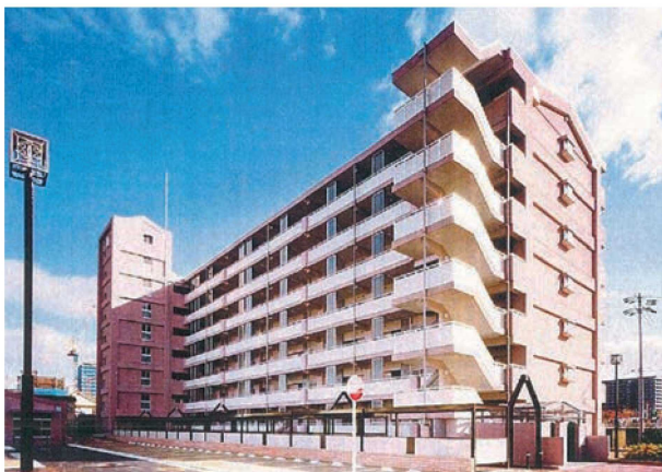
A地区 都市再生住宅
