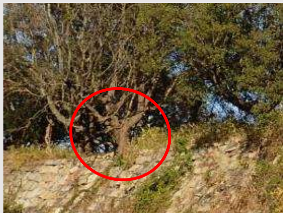
【本丸西】（2021年12月） 樹木の生長や、地震・台風等による倒木で、石垣を壊す恐れがある。
