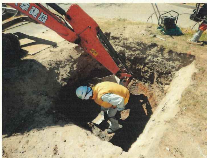
調査風景 人力掘削
