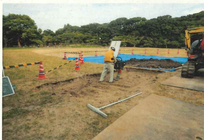
調査風景 埋め戻し
