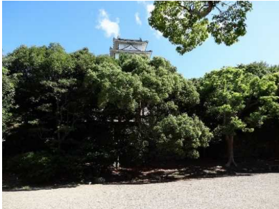
生い茂った樹木による景観阻害
