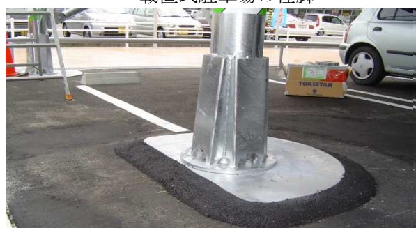
載置式駐車場の柱脚
