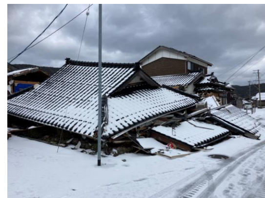
倒壊した木造建築物
