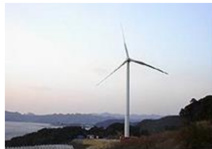
【風力発電施設の設置例】
