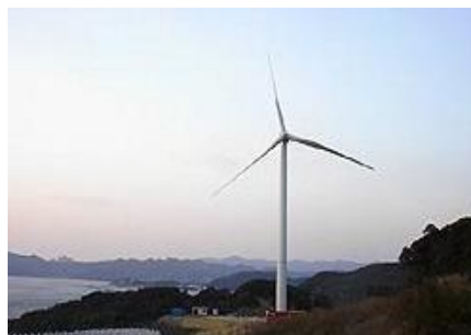
風力発電施設の設置例
