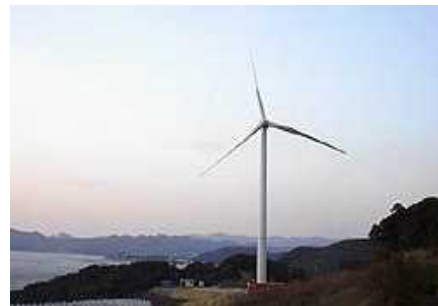
風力発電施設の設置例
