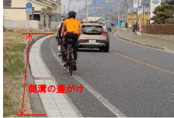
狭隘区間での路肩幅確保
