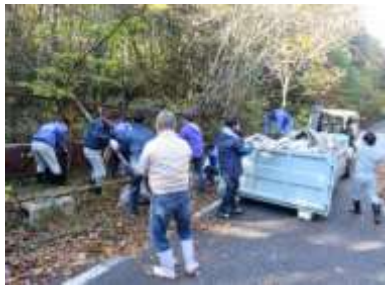
積み込み作業
