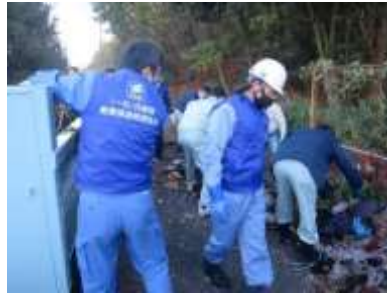
積み込み作業
