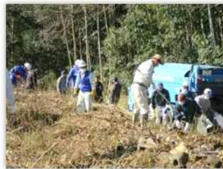
◆不法投棄撤去作業の様子
