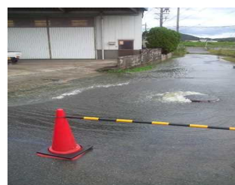
【マンホールからの溢水状況】
