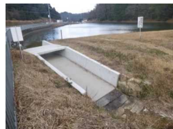
【ため池の簡易部分補修】
