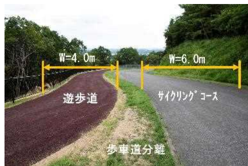
歩車道を分離したサイクリングコース（加東市）
