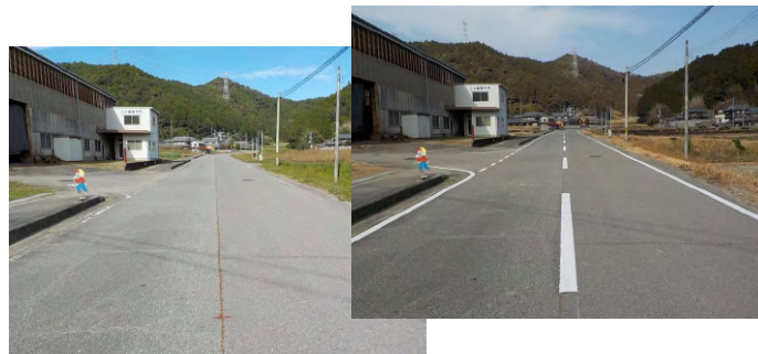
道路区画線の引き直し (一)下滝野市川線(加西市)
