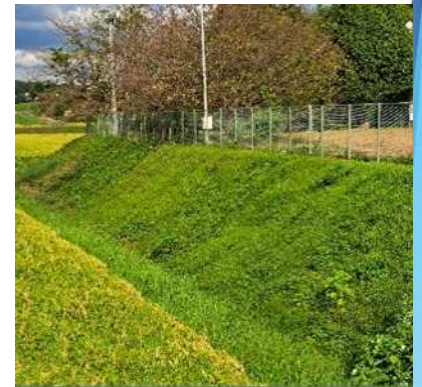
施工から5ヵ月後
