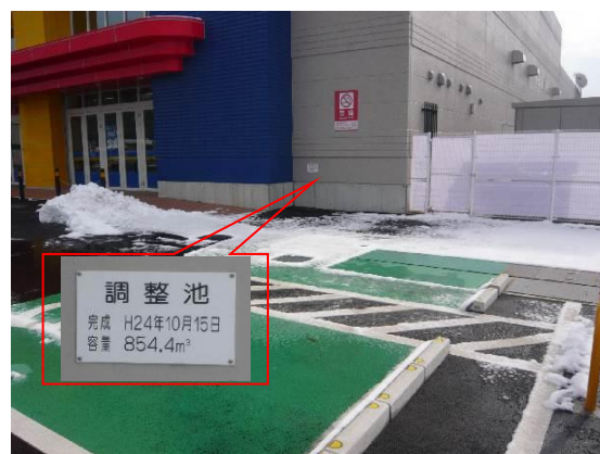
図 11 ケーズデンキ氷上店の 地下雨水貯留槽
