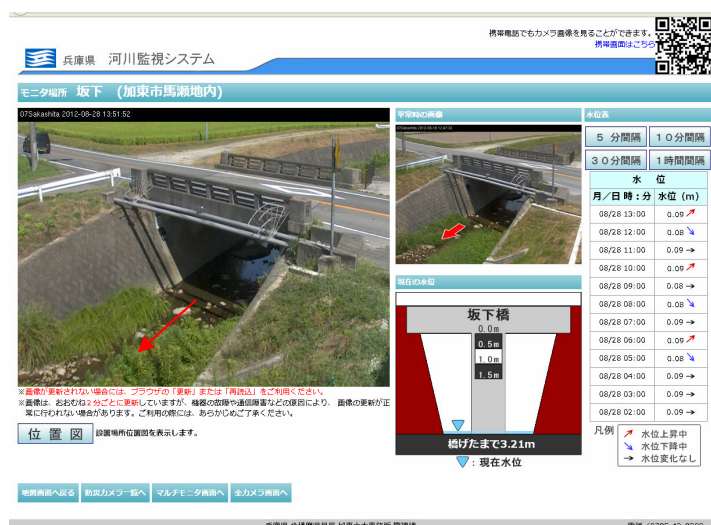
図 2.3.5 兵庫県 河川監視システム
