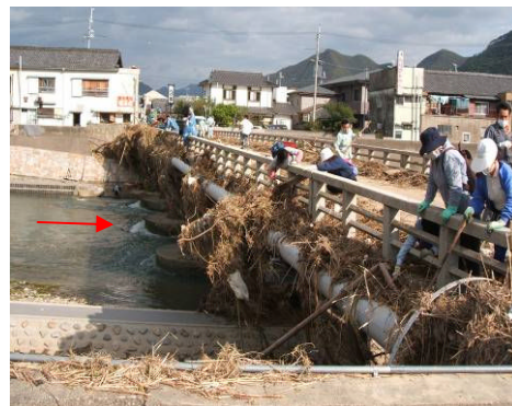
写真 1.2.6 杉原川 西脇市由縁橋被災状況
