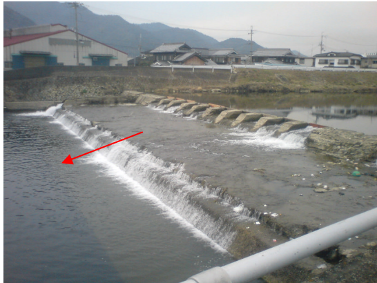
写真 2.1.1 沖田井堰（杉原川）の現状
