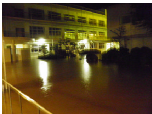
写真 1.2.7 杉原川の氾濫（多可町 中町南小学校）
