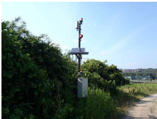
写真 2.3.1 やすらぎの景観警報装置 (東条川小野市)
