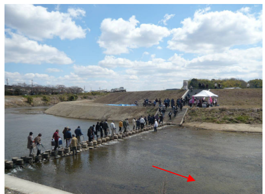
写真 2.1.3 親水型の護岸整備（東条川小野市）
