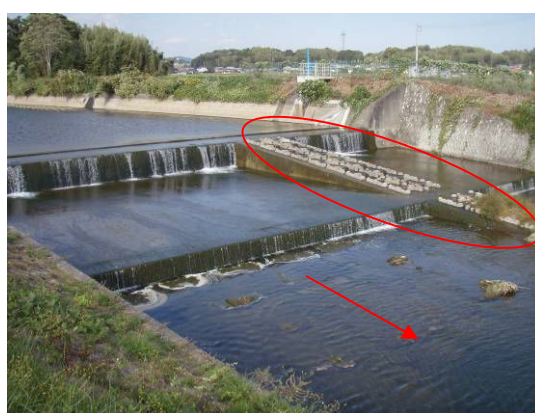
写真 2.1.5 魚道の整備（万願寺川加西市）
