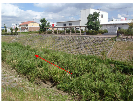
写真 2.1.4 階段護岸の整備（金剛寺谷川三木市）
