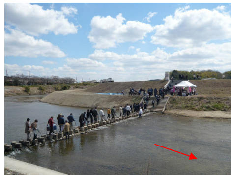
親水型の護岸整備の例 東条川 (小野・加東ブロック)
