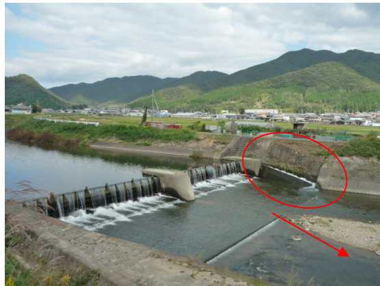
魚道の整備状況 野間川（西脇・多可ブロック）
