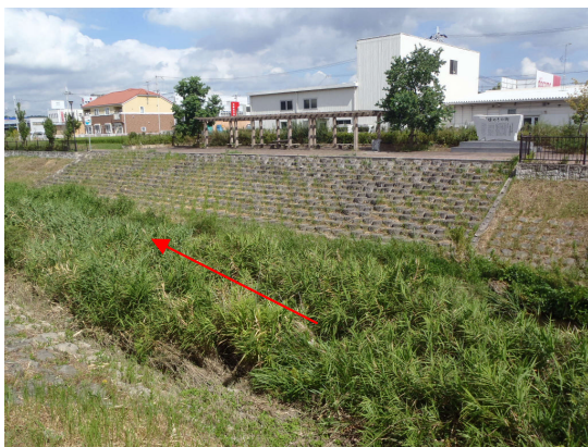
写真 2.1.5 階段護岸の整備（金剛寺谷川三木市）
