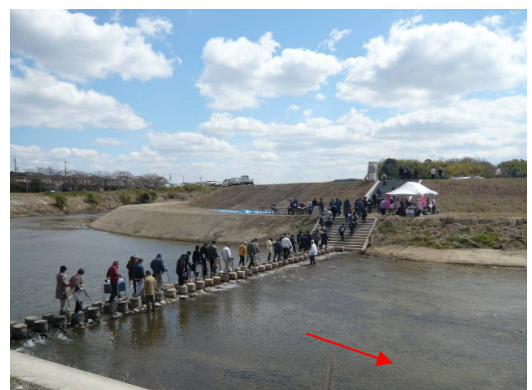
写真 2.1.4 親水型の護岸整備（東条川小野市）
