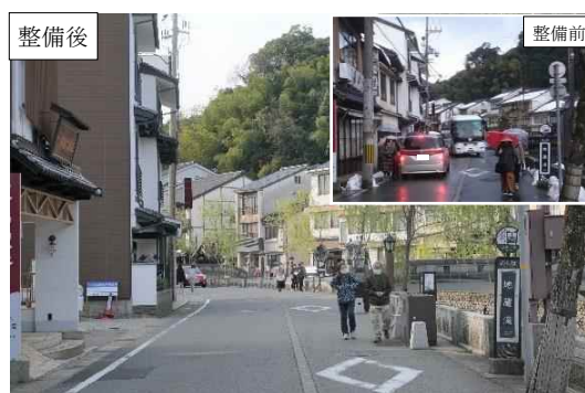
無電柱化対策
