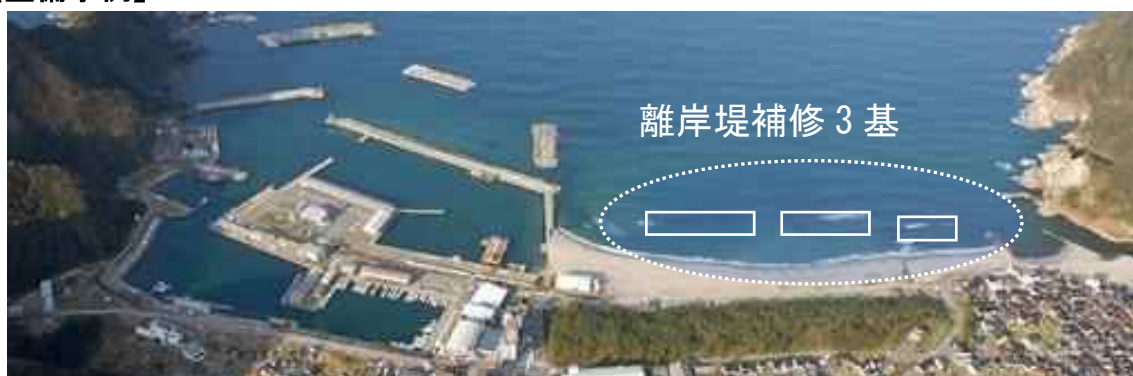
漁港海岸離岸堤補修
