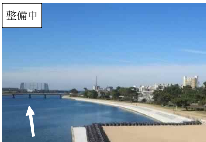
河川改修(護岸、河床掘削等)
