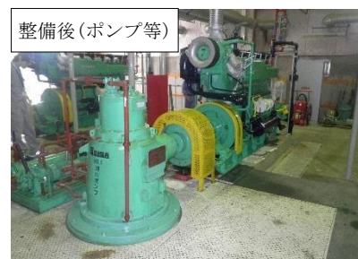
排水機場(ポンプ等修繕)
