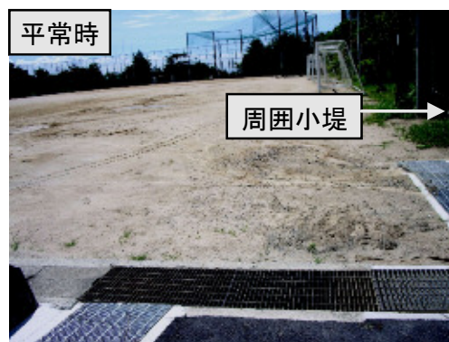
県立宝塚東高校(大雨時に雨水を校庭に一時貯留)
